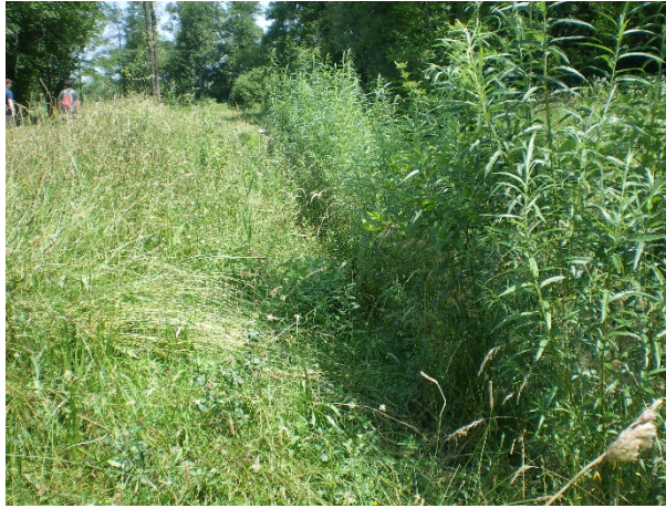
Figure 9. Aménagement de berge à base de fascines de saules (chantiers Cariçaie)
